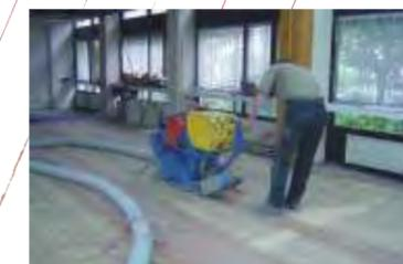
Solide Basis für langlebiges Resultat: Perfekte Untergrundvorbereitung im Kugelstrahlverfahren.
