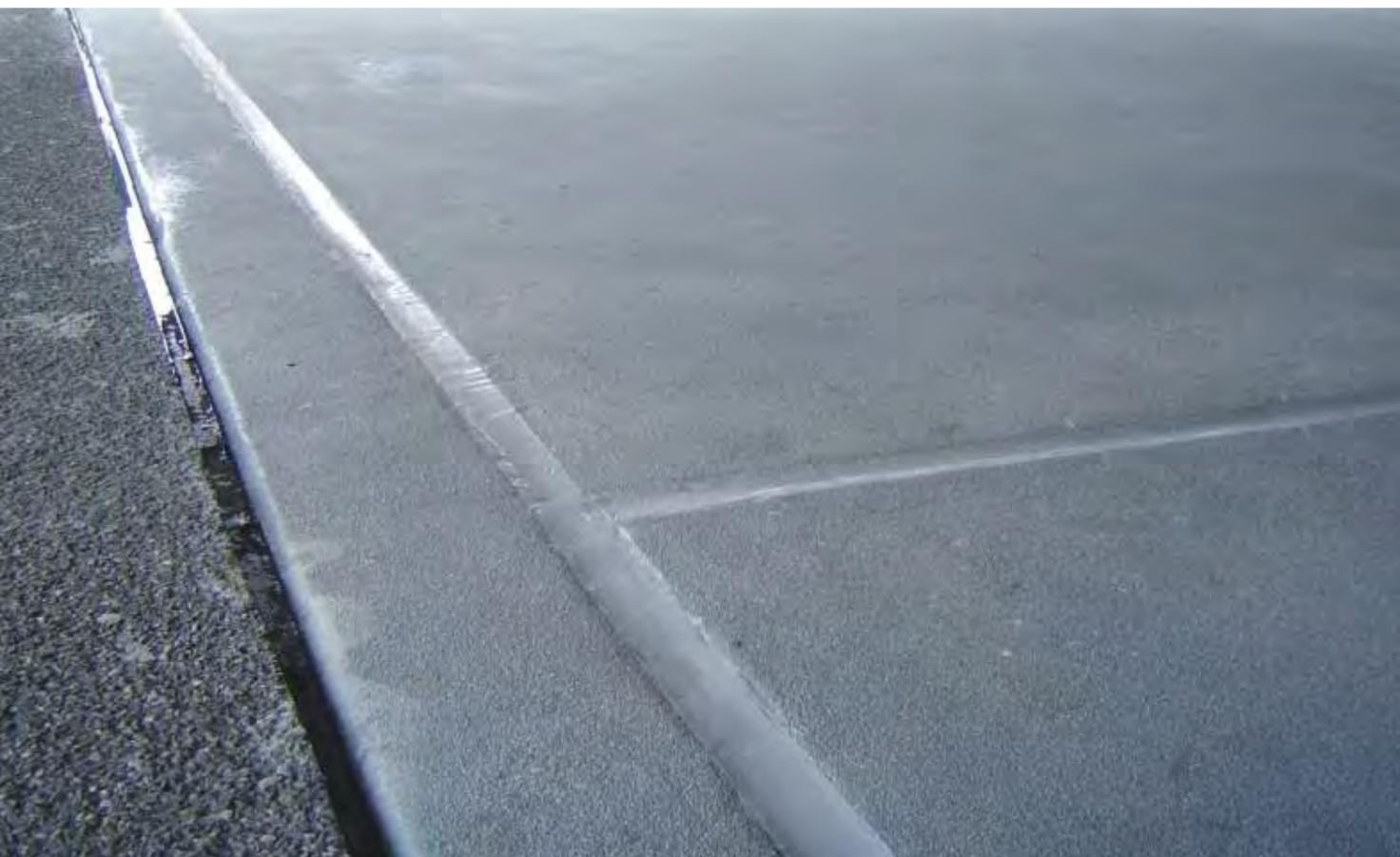
Abdichtung eines Parkdecks: Rissüberbrückende Ausführung eines Einstreubelages auf mineralischem Untergrund. Dank der guten Verträglichkeit mit anderen Baustoffen und Materialien und der ausgezeichneten Haftung sind der Anschluss an einen Schwarzbelag sowie die Ausführung der Fugen problemlos.
