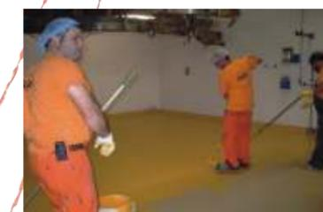
Auftragen eines Fliessbelages auf EP-Basis auf die leicht abgestreute Grundierung: Alles in einem "Guss".
