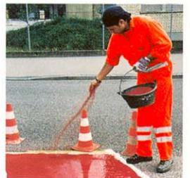
**Bei 20 °C ist die neue Beschichtung bereits nach 120 Minuten voll verkehrstauglich.**
